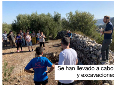
Intervención de consolidación en las murallas del Castillo.
