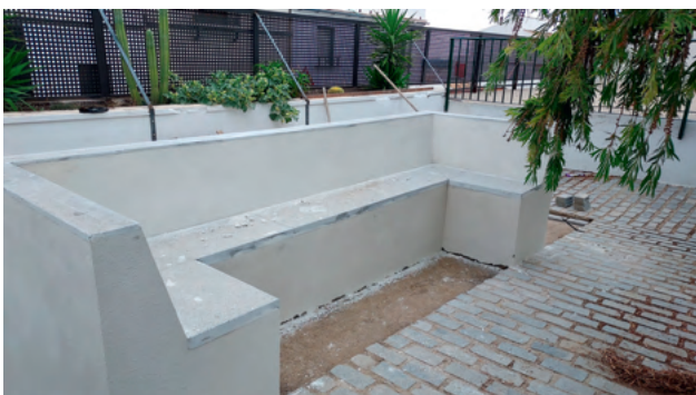
Intervenciones en el parque de la calle Mina.
