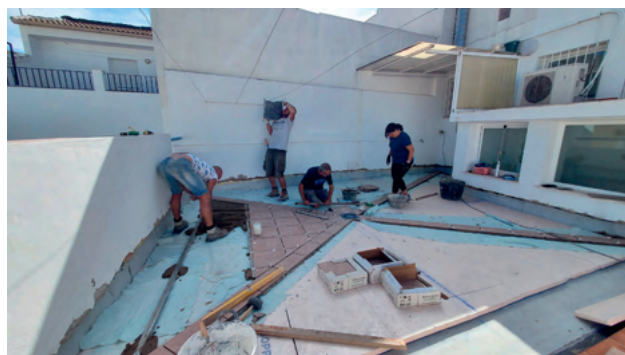
Arreglo de las terrazas de la guardería.
