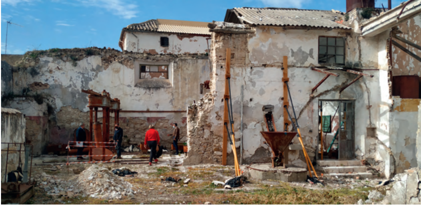
Estado inicial antes de las obras
