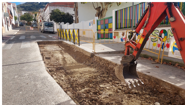
Actuación en la calle Junco, con arreglos en el pavimento.
