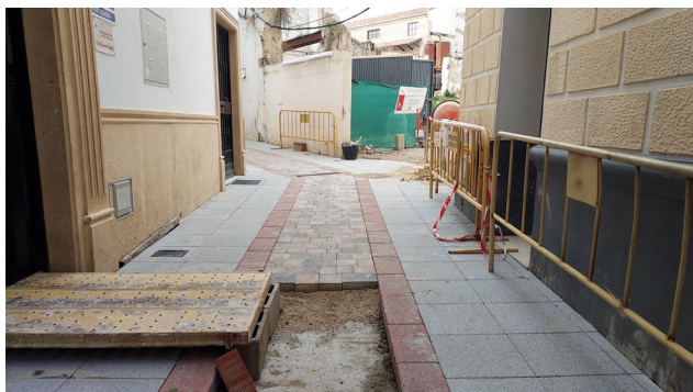
Terminación de la pavimentación de la calle Obispo Cubero.
