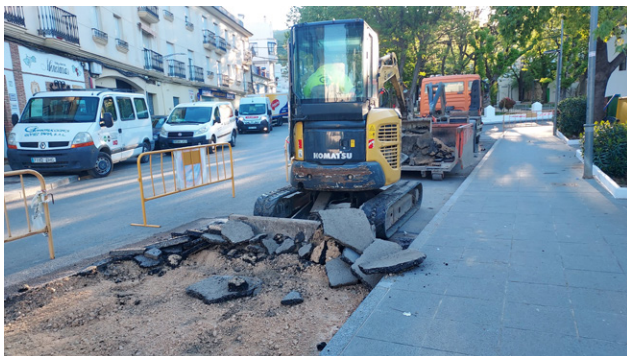
Arreglo del socavón de Ronda Povedano
