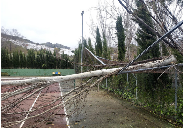
Caída de álamos sobre el cerramiento de la pista de tenis
