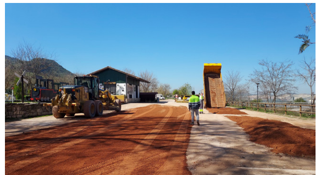
Mejora del firme del aparcamiento de la estación
